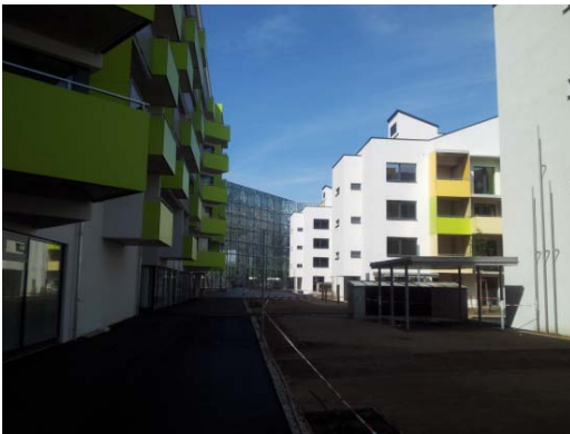
Aussenansicht WHA Kaiserermühlenstrasse, Wien
